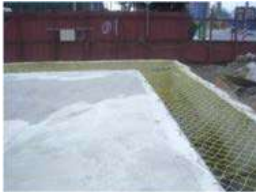
圖2.傳統處理方法: 架設安全網
