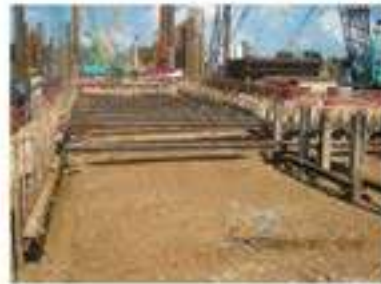
Installation of 1 st level struts 安裝第1層支柱
