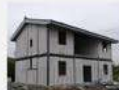
鋼板梁+牆板實際結構造形
