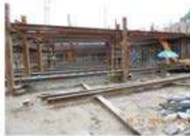
Installation of 2 nd level struts 安裝第2層支柱
