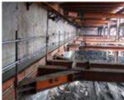
圖3.傳統處理方法: 架設安全網
