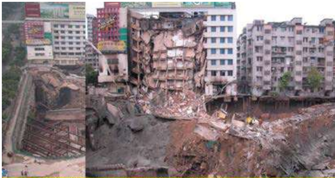
2005年7月21日廣州海珠區江南大道南珠城海廣場深基坑垮塌，致3人死亡，4人受傷
