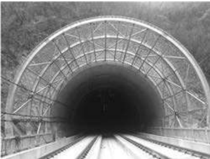
图 8 桥隧一体化柔性钢棚洞施工照片
