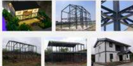
沙盤模型；施工過程；完工後外觀效果
