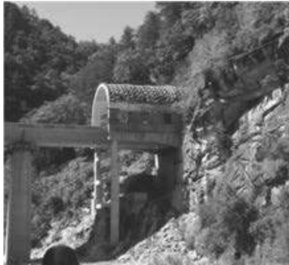
图5 柱、梁支撑式钢筋混凝土棚洞施工照片
