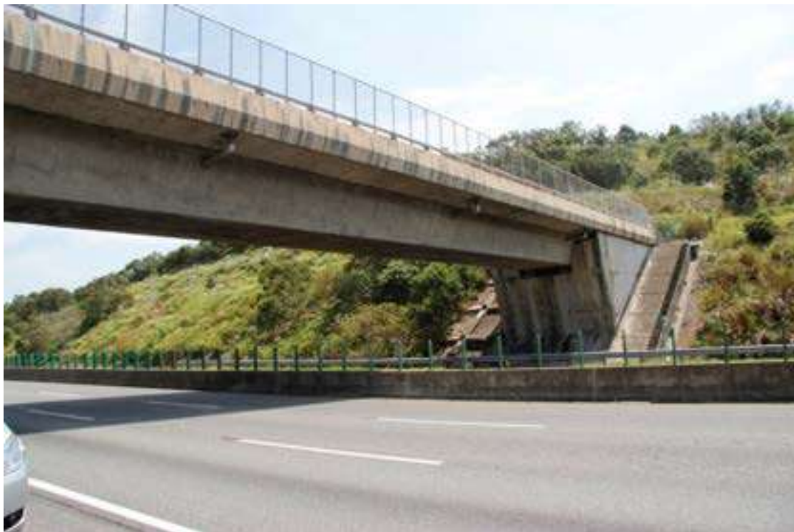
圖二 邊坡現場照片
