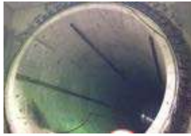
圖 10 隧道內槽鋼拉結實景圖
