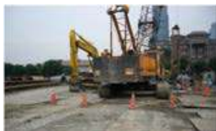
圖13. 傳統於工地 架設警示三角錐
