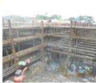
Installation of 3 rd level struts 安裝第3層支柱
